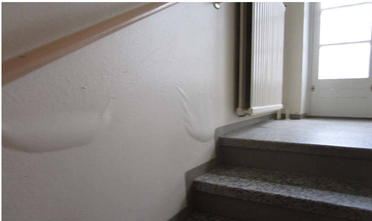
Kuva 5. Rappukäytävässä on havaittavissa vesipusseja.
