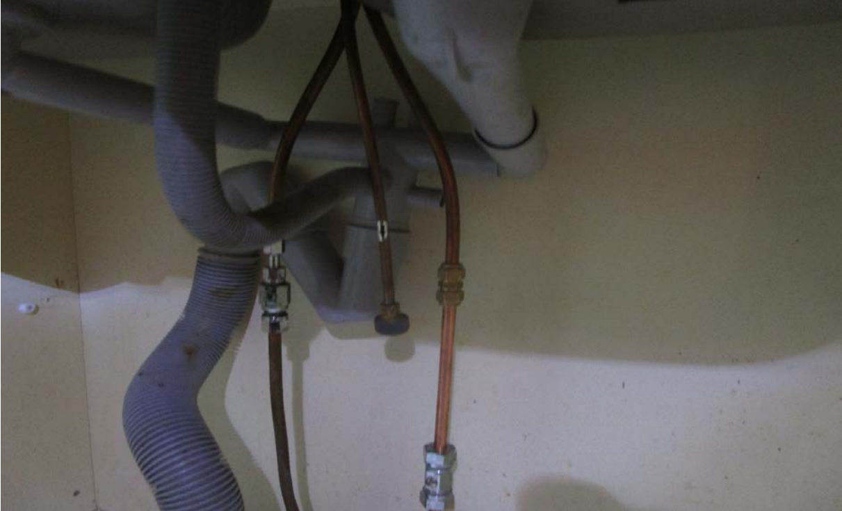
Kuva1. Vesivuoto aiheutui allaskaapin hajonneesta vesiputkesta asunnossa 4. Kuvassa putki uusittuna.
