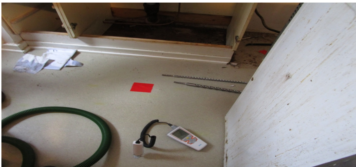
Kuva 6. Eristetilanmittaus menossa huoneisto 4:n keittiössä.
