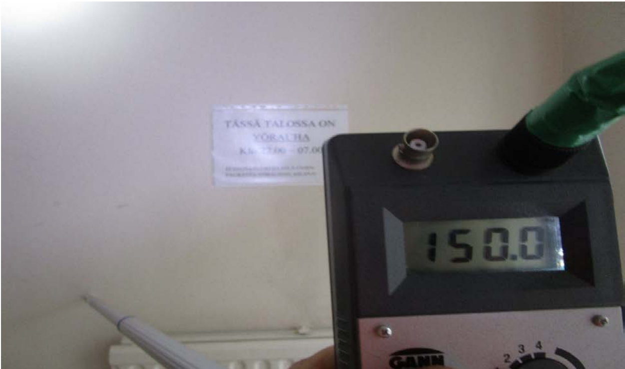
Kuva 3. Porraskäytävän ja keittiöiden välinen seinä on kostea.
