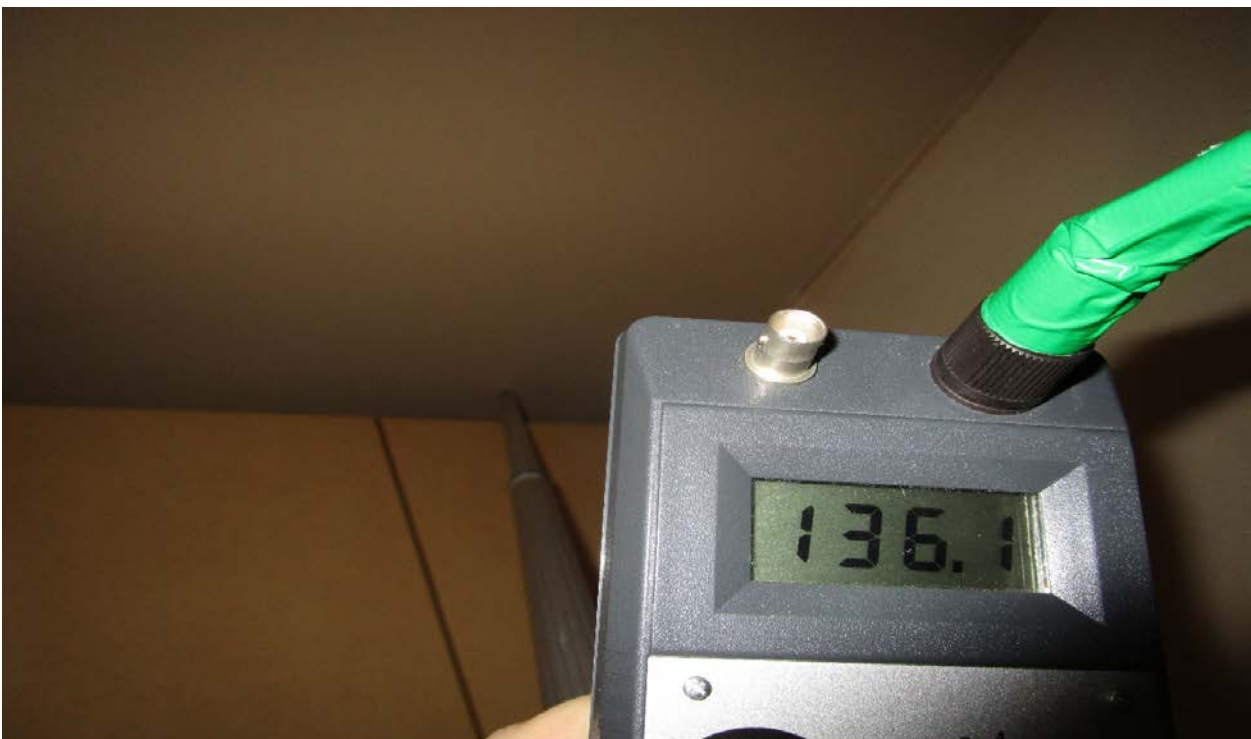
Kuva 4. Asunnon 2 keittiön katto ja kaapiston takana oleva seinä ovat märät yläkerran vesivahingosta johtuen.
